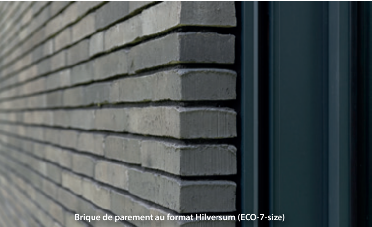
Brique de parement au format Hilversum (ECO-7-size)
