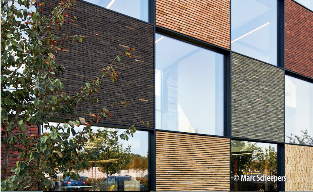
Au total, 128 surfaces de démonstration ont été parées de briques et pavés, tant à l'intérieur qu'à l'extérieur du bâtiment.
